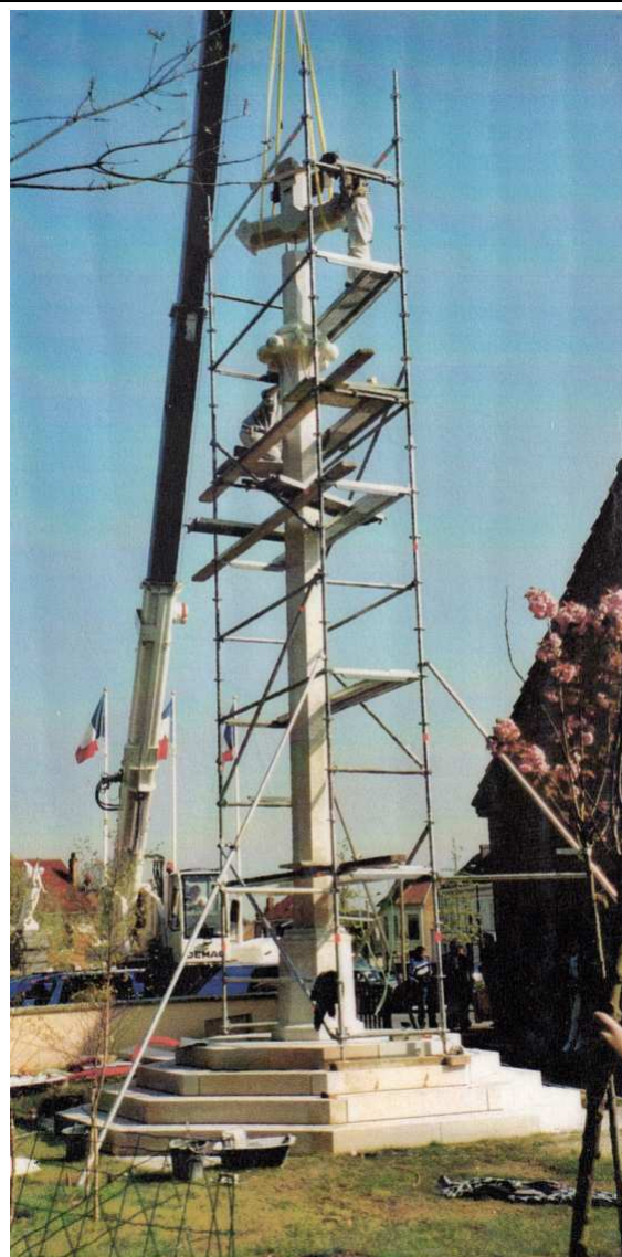
Mise en place du croisillon
