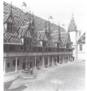
La cour et la toiture
